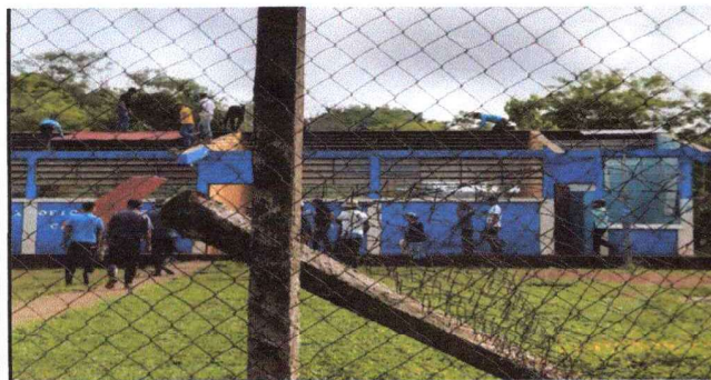
Foto 5: desmontaje de techos 1
