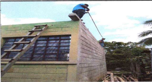
Foto 1: Medición de distancias de la colocación de las vigas (costaneras)
