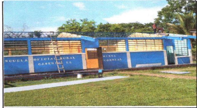
Foto 4: lijada y limpieza de joins
