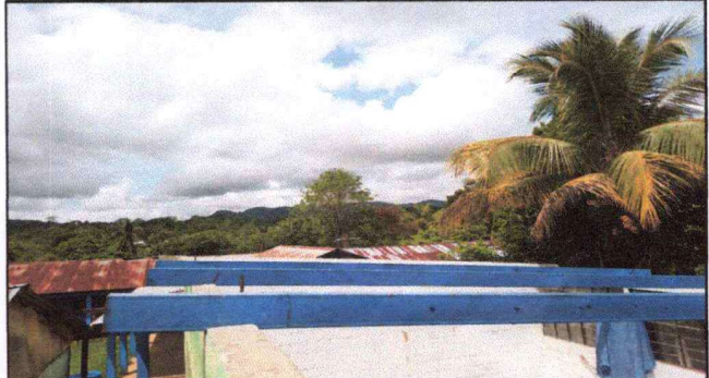
Foto 2: cuando esta colocada de costaneras de 2" x 6"
